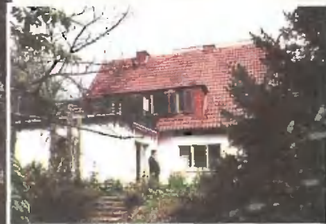
Дом до реконструкции (вид со стороны сада)
