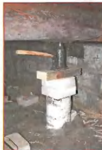
Чтобы разгрузить заменяемое бревно, использовал домкрат, поочередно устанавливая его под балки перекрытия
