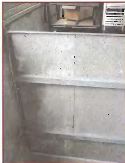
Для крепления каркаса перегородки к стене использовал шурупы с шайбами и резиновыми прокладками. Между стеной и перегородкой установил прокладки из звукопоглощающего материала
