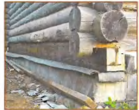
После выравнивания блоков в одну линию, все стыки и зазоры были уплотнены паклей
