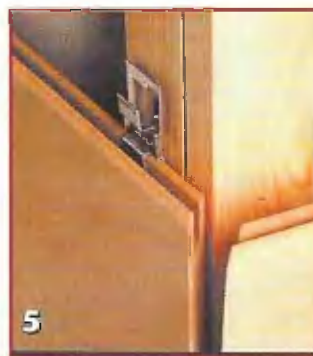
Рис. 1. Скобы (клямеры), применяемые для крепления шпунтованных досок и панелей:
