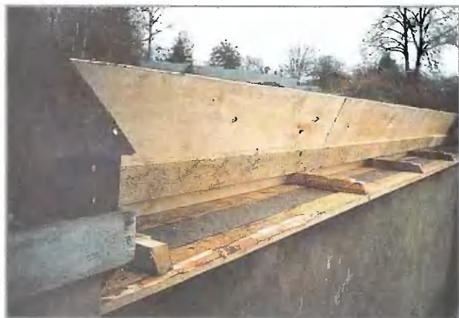
Детали ската соединены досками, с помощью которых фанерные щиты опираются на основание навеса
