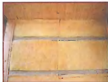
Для лучшей звукоизоляции пространство между вагонкой и шифером заполнил минеральной ватой «Изовер»
