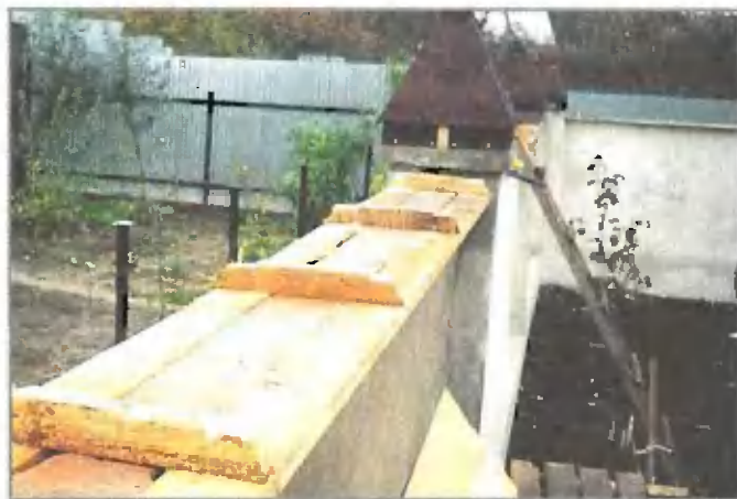
Доски подшивки ориентируют конструкцию навеса относительно стены
