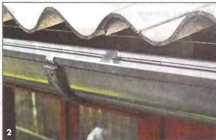
Даже при неравномерном шаге между стропилами водосливный желоб установлен с плавным перепадом высоты
