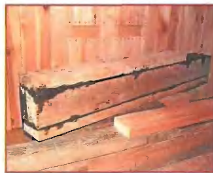
Удаляемые части бревна заменил блоками, собранными из обрезных пиломатериалов различных сечений
