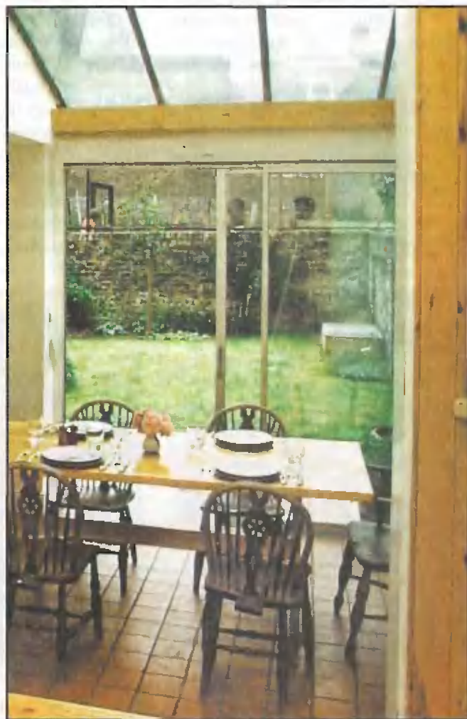
В стене между пристройкой и старой гостиной сделали проем. Внутренний дворик накрыли остекленной крышей и сделали раздвижные двери, выходящие в сад. На пол уложили керамическую плитку
