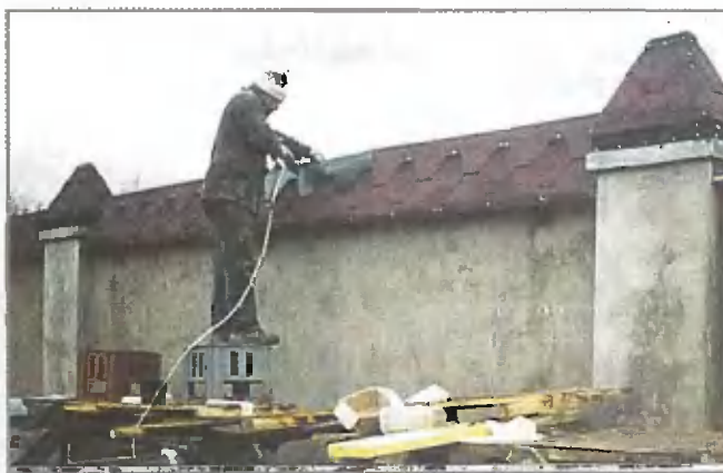
Отделка навеса кровельным материалом. Клеевую сторону мягкой черепицы прогревают феном
