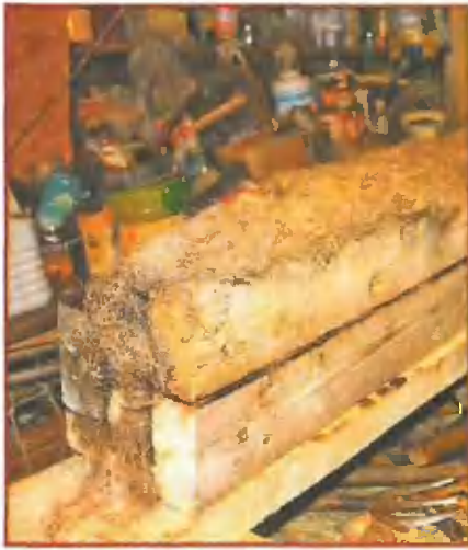
В качестве теплоизоляции я использовал паклю
