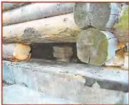
Первый фрагмент бревна вырезан. Можно устанавливать замещающий его блок
