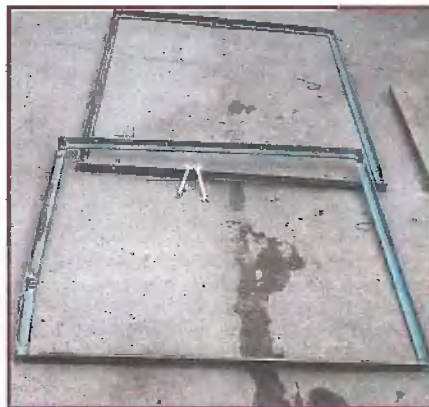
Если раскрутить болты, получим две части каркаса, которые теперь легко перевезти в квартиру и собрать по месту. Покрасил каркас я также в гараже, чтобы не заниматься этим в закрытом помещении
