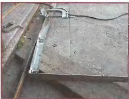
Каркас перегородки — не прямоугольный, он должен соответствовать форме проема
