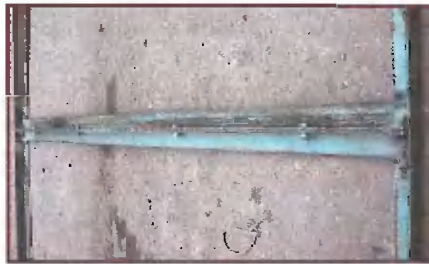
К собранному каркасу перегородки приварил два уголка, соединенных болтами
