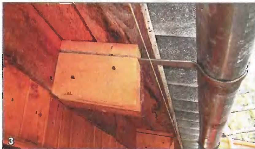
Упрятанные в толщу древесины кронштейны не создадут препятствий для отделки свесов стропил
