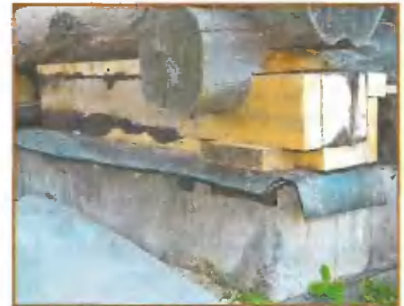
Первый блок установлен
