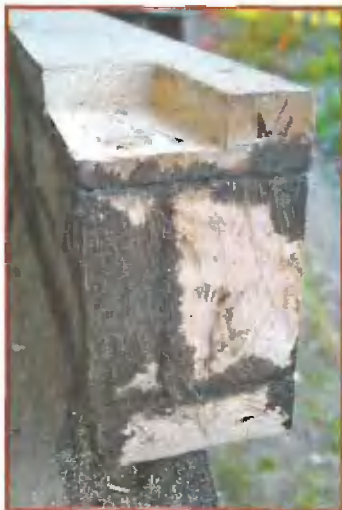
Паза под концы балок перекрытия выбраны до установки блоков на цоколь
