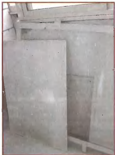
Открутил болты и аккуратно снял шифер со старых перегородок — он еще пригодится
