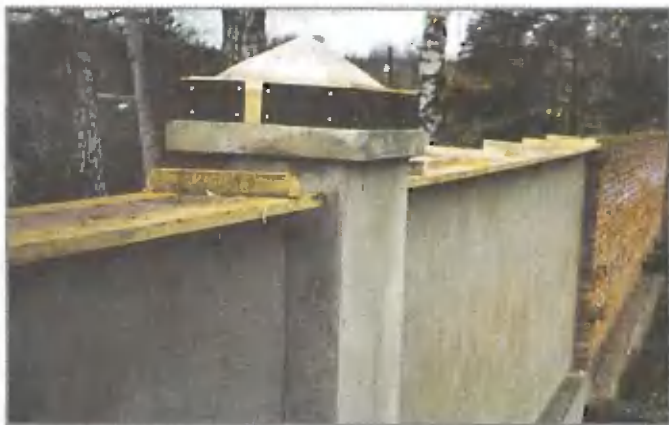
Собранные из досок сечением 25x100 мм рамки служат основанием колпаков
