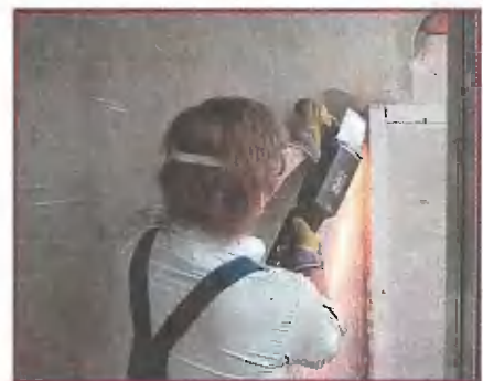
Работу начал с демонтажа старых перегородок
